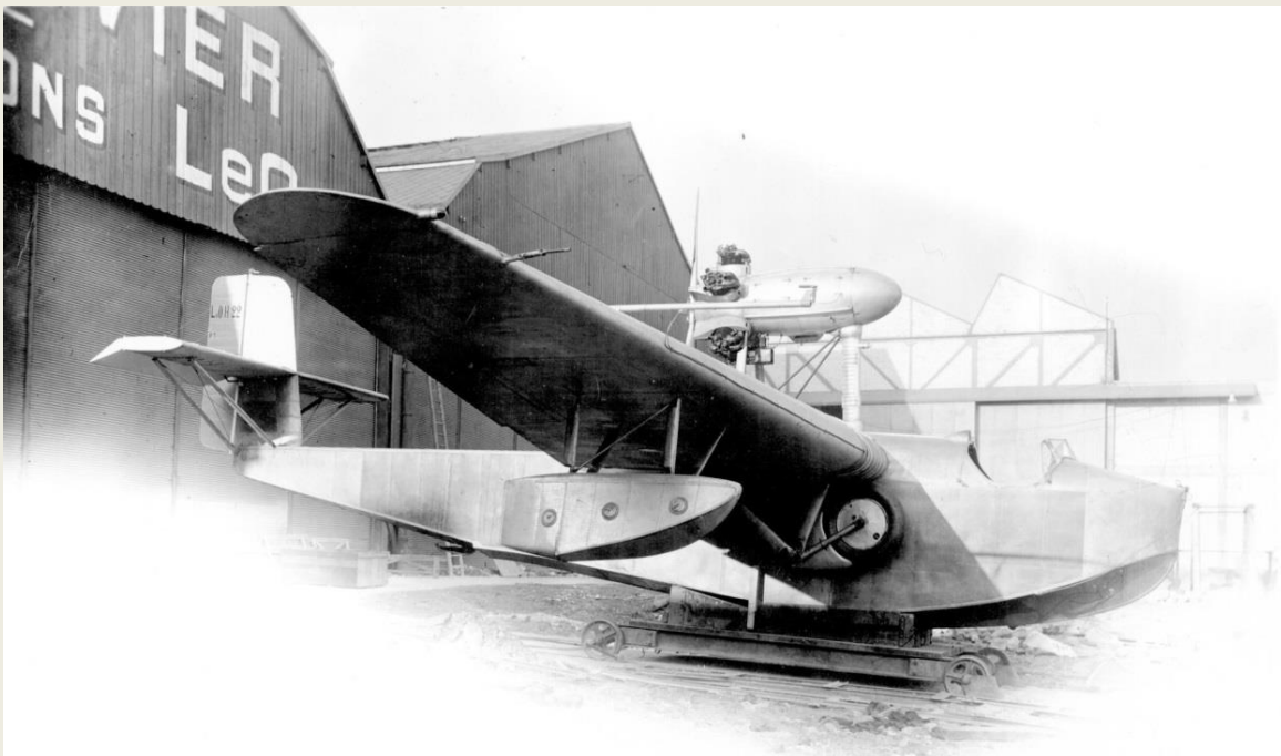
Construit tout en bois, l'hydravion léger Lioré et Olivier H-22, grâce à un moteur Lorraine « Mizar » de 240 ch moderne, transportait en 1931 jusqu'à 500 kg de charge (fret postal) sur 650 km (traversée de la Méditerranée) à 145 km/h. Son train d'atterrissage relevable est signé Messier. Il est photographié ici sur le slip d'Argenteuil. (Collection Arnaud Delmas).
